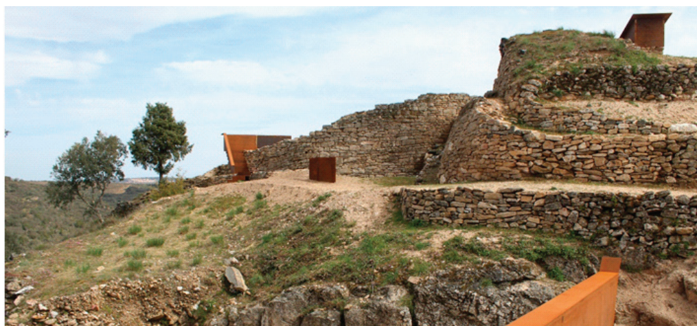
CASTELO DOS MOUROS DE VILARINHO DOS GALEGOS – 2023 – SECTOR NORTE E FOSSE APÓS A INTERVENÇÃO DE CONSERVAÇÃO E RESTAURO 2ª FASE.
