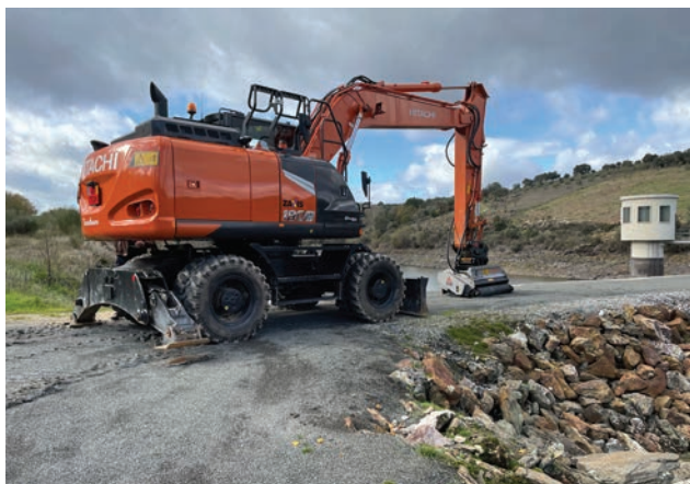
Desmatção e regularização do caminho circundante à Barragem de Bastelos, nas Freguesias de Penas Roias e Azinhoso
