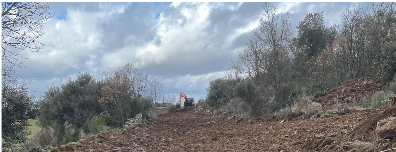
Arranjo e abertura de Caminhos na Freguesia de Saldanha
