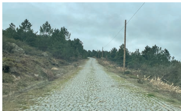
Desmatação de berma de caminho da Serra da Castanheira, na União de Freguesias de Brunhosinho, Castanheira e Sanhoane
