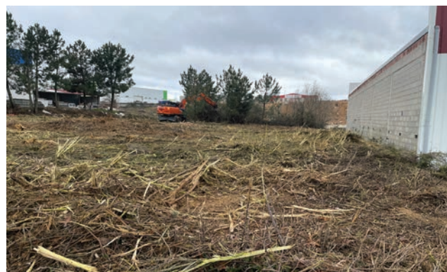
Desmatação na Zona Industrial, em Mogadouro
